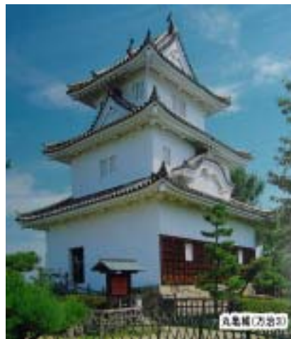
丹波亀山城 最上階以外の破風のない天守。 5重5階 左南面 右西面（初期層塔型天守）（図は「天守のすべて 学研」より）
