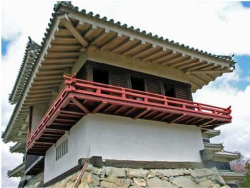
月見櫓の特徴は、三方に巡らした**回縁**（まわりえん・廻縁とも書く）でしょう。約107、6cmの持ち出しで、14本の腕木によって支えられています。1階床の梁や根太の下端で押さえられています。回縁の部材（腕木・高欄・根太・縁板まですべて檜材です。回縁の南東と北東の隅に施された高欄は、風格のある**勿高欄**（はねこうらん）としています。
