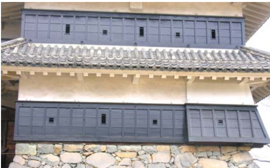
乾小天守の狭間の付け方(東面)
