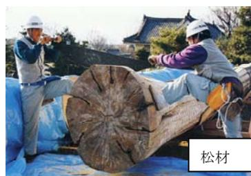
8 太鼓門の柱の底面を土台の石の上に密着させるために、石の上にある物質をぬり、柱を立て、その物質が付着している部分を根気よく削り、石と密着させるための作業が幾度となく繰り返されました。この技法を「<sup>ひかりづ</sup>光付け」といいますが、土台となる石の上に塗った物質は为什么呢。
